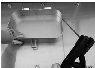
④枠を溶接します （周囲、装置内の可燃物を除去します）
