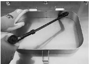
⑤枠に沿って点検口を切断します （周囲、装置内の可燃物を除去します）
